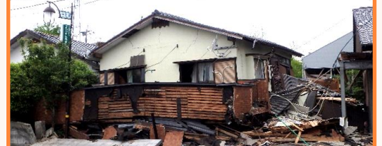
▲熊本地震で1階がつぶれた住宅
