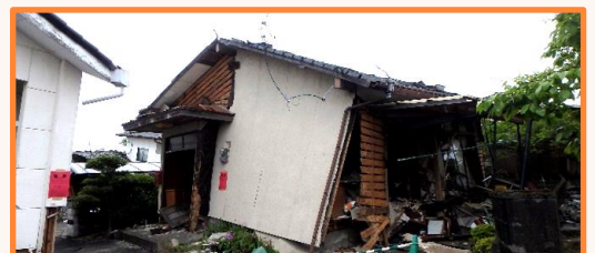
▲熊本地震で倒壊した住宅
